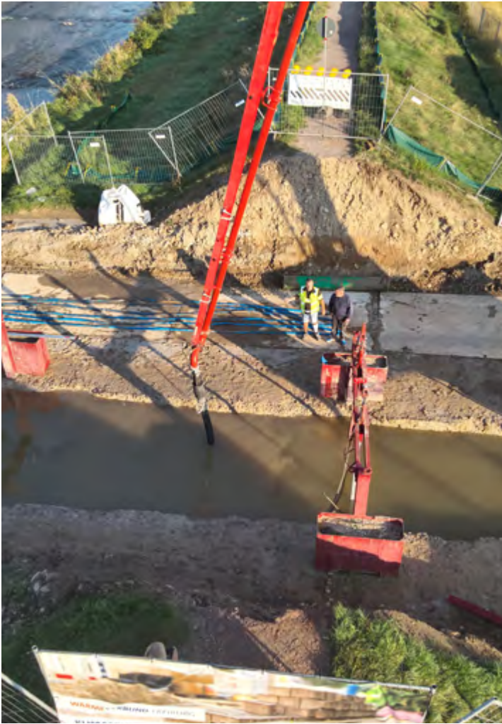
Verfüllung unter Wasser
